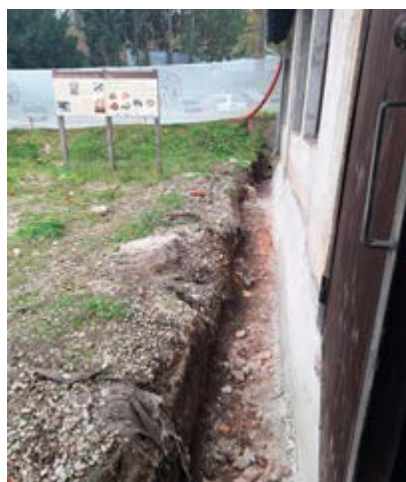
Dela pri obnovi krčilne kovačnice/štauharije
